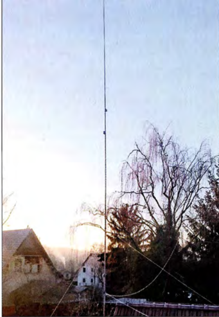
Bild 4: Betriebsbereite Antenne, unten nach vorn zeigend der Anfang des 80-m-Radials, schräg nach rechts hinten das 40-m-Radial; darüber die Abspannungen des GFK-Masts
