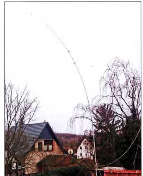
Bild 10: Sturmtief Axel strapazierte Mast und Antenne gewaltig – aber beide hielten es aus.
