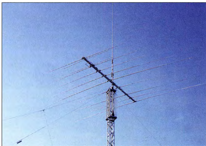
Bild 1: Ansicht der Mastspitze mit dem darauf angeordneten Beam und einer Vertikalantenne sowie der zur linken Seite hin gespannten Sloper-Antenne
